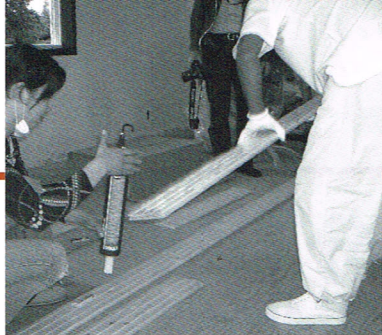
夫婦で床板材を貼る。愛着ある家はこうした作業から生まれる
